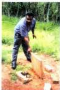
Marcos Lopes mostra que a fossa está cheia e a céu aberto.
