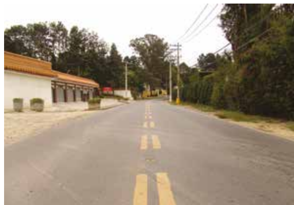
(2) Estrada Fernando Nobre, falta de transporte
