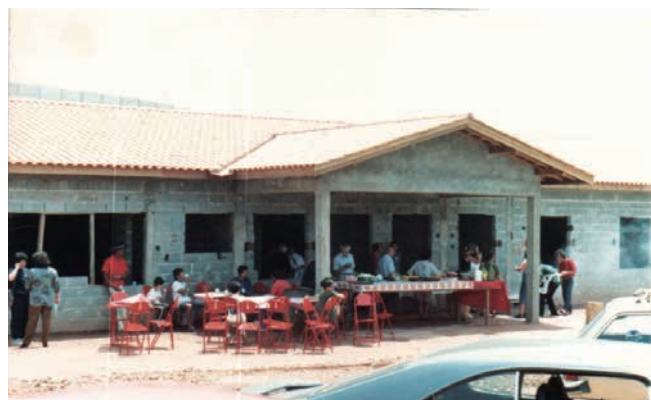
A Casa de Apoio durante a sua construção.
