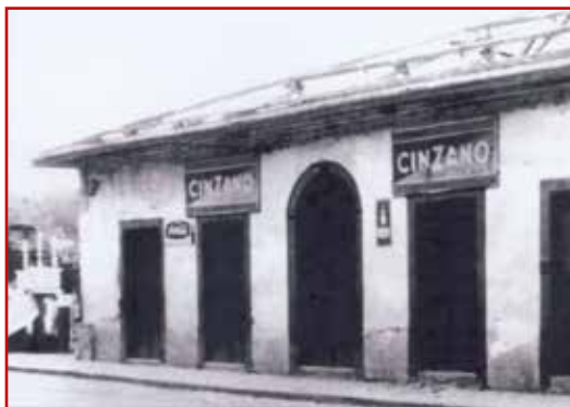
O casarão localizava-se à Rua Senador Feijó, próximo à Travessa do Felício
