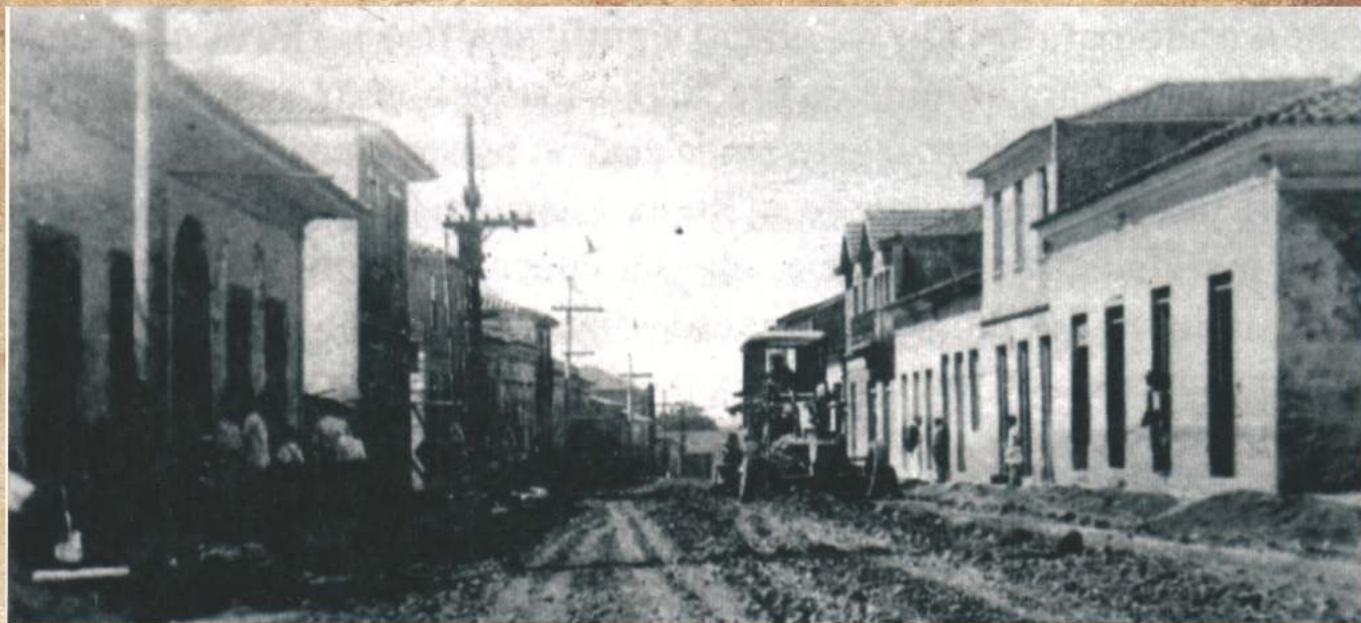
Rua Senador Feijó, sendo preparada para a colocação de paralelepípedos.
