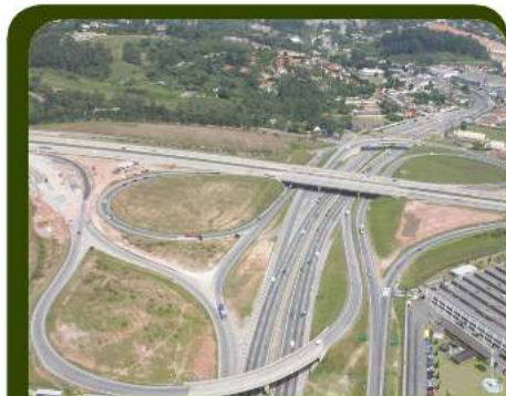
46 RODOANEL Obras entregues
