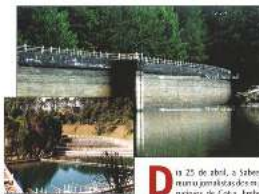
An silo represa Pedro Beicht com nível de água bem abaixo do normal. ACRN, e STA - Estação de Tratamento de Água, no município de Morro Grande, Cotia.
