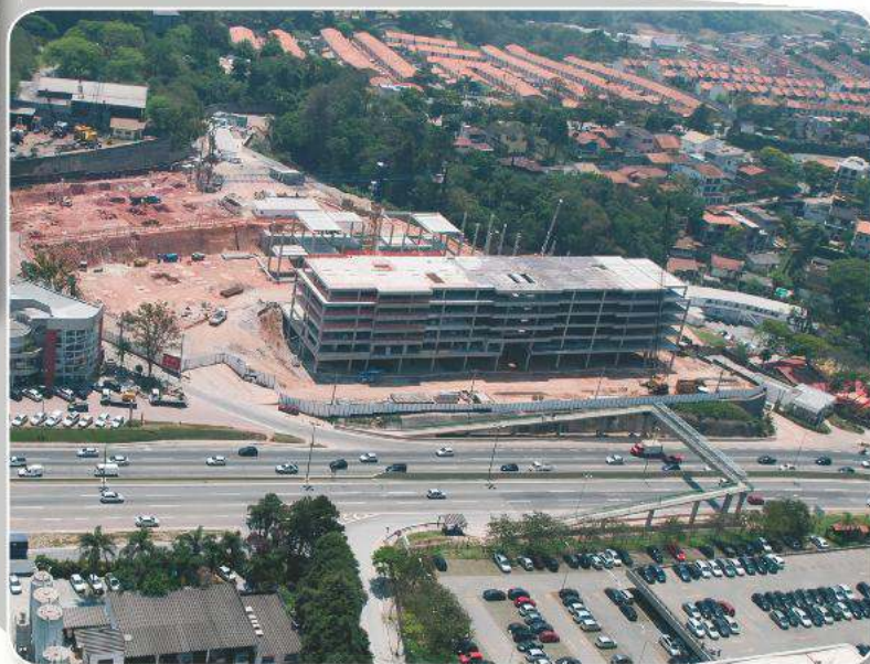
À direita, destaque da obra do empreendimento The Square.
